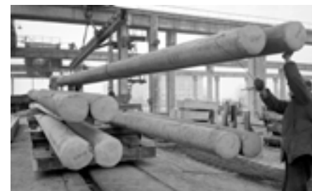
Gelžbetoninių dirbinių gamykloje gaminami elektros stulpai naujoms elektros linijoms. V. Bražo nuotr., 1961, LCVA, 0-017593-2
