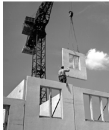
Montuojamas 80-ties butų namas iš blokų, pagamintų Vilniaus gelžbetoninių dirbinių gamykloje. M. Baranausko nuotr., 1959, LCVA, 1-07379
