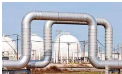
5 Išlankos būtinės, kad dėl temperatūros pokyčių vamzdžiai nesutrūkinėtų.
